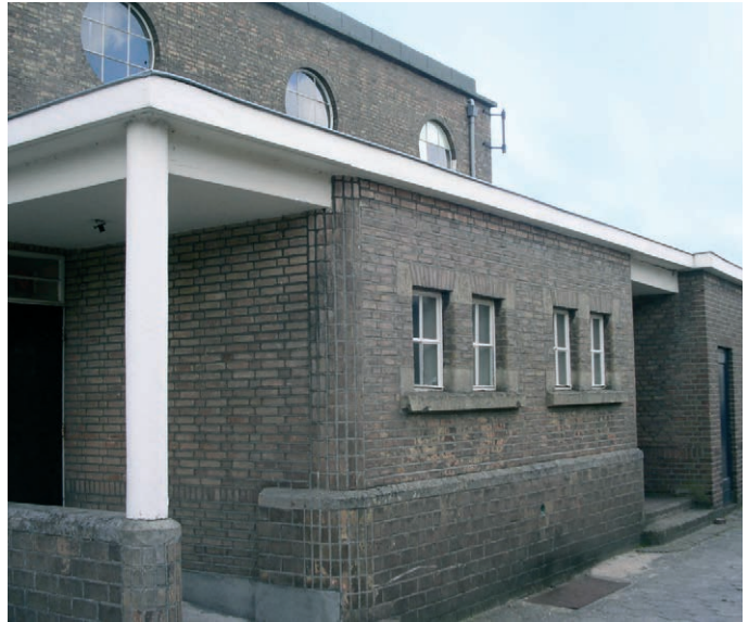
Zijgevel van de kantine
